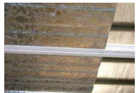
Bước 11c: Lắp phụ kiện Bonstrip Step 11c: Bonstrip
