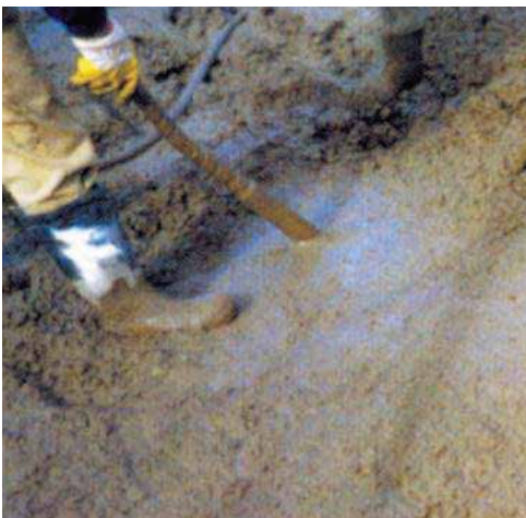
Bước 9: Đổ bê tông Step 9: Place concrete
