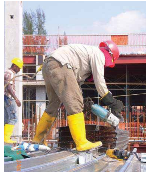
Bước 4: Cắt các tấm sàn BONDEK® II nếu cần Step 4: Trim BONDEK® II sheets, if required
