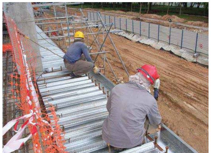
Bước 6: Lắp đặt hệ diềm bao Step 6: Install Edgeform
