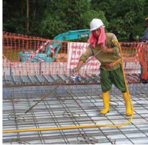
Bước 8: Làm sạch bụi bẩn và rác thải Step 8: Remove dirt and contaminants
