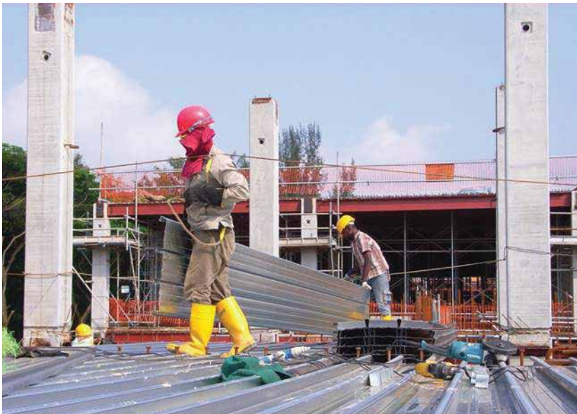
Bước 3: Lắp các tấm sàn BONDEK® II Step 3: Lay BONDEK® II sheets
