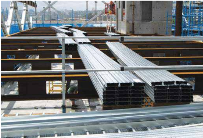
Bước 1: Đặt các bó sàn BONDEK® II trên hệ đỡ Step 1: Place BONDEK® II sheet bundles on support
