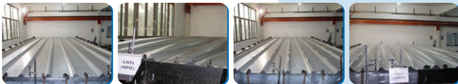
Thí nghiệm sóng tôn chịu tải trọng gió (gió bốc) - Wind uplift test
